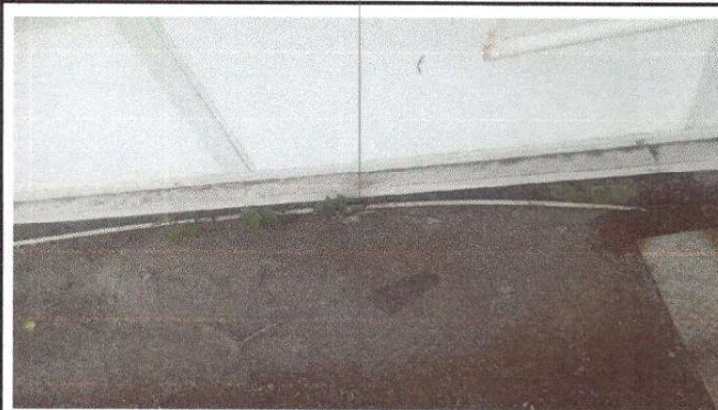
Foto 2: Sustitución de tubería línea principal
